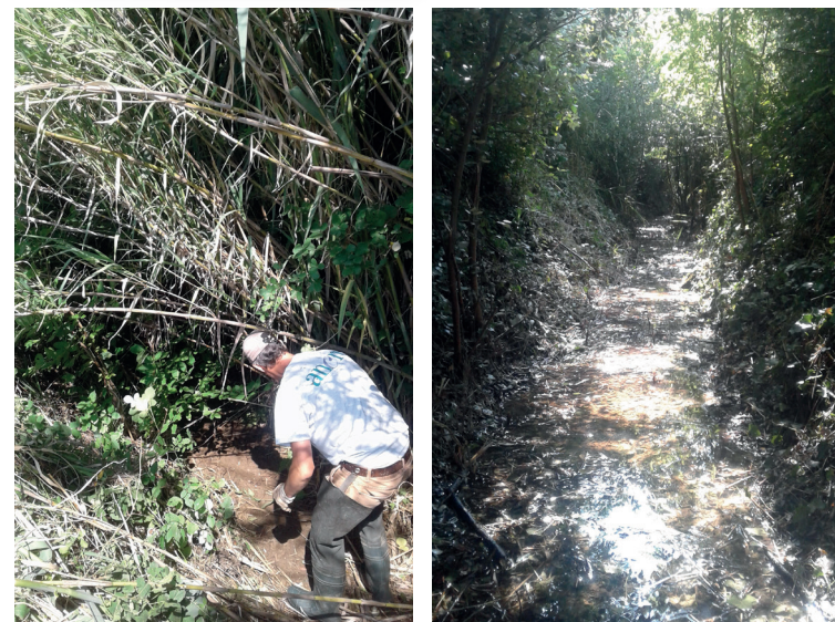
Débroussaillage du lit mineur des Echaravelles : avant / après (2023)
