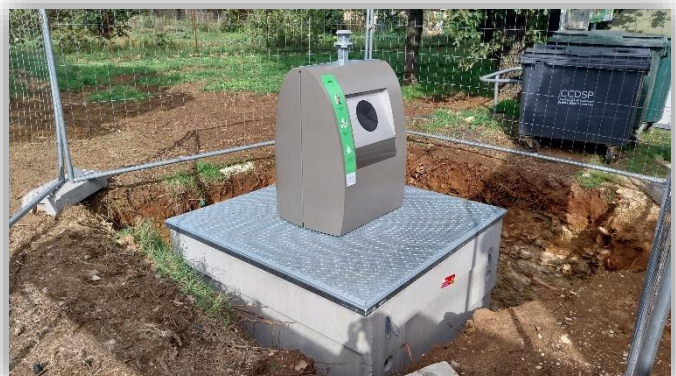
Travaux Suze la Rousse
