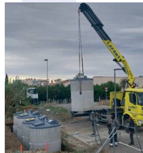
Travaux Donzère - Point d'apport volontaire complet
